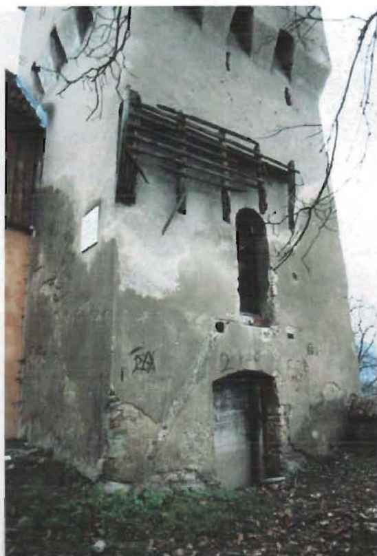
Turnul Cojocarilor înainte de intervenția MET
